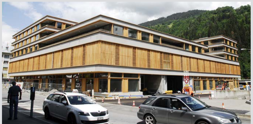
Das Zentrum Marceau wird im September 2018 eröffnet. Es ist ein städtebaulicher Markstein für Ilanz.
