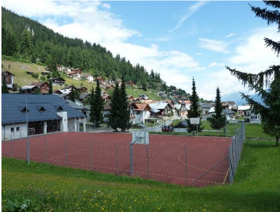
Ortsansicht von Westen Auch am westlichen Ortsrand verunklaren Neubauten und Sportanlagen die Abgrenzung des ursprünglichen Ortskerns.
