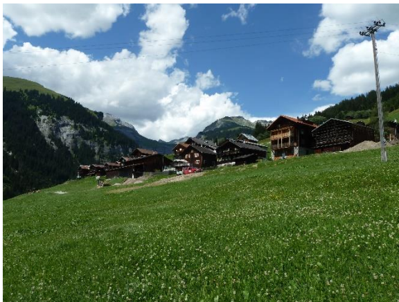
Ortsansicht von Südwesten Gegen Südwesten sichert die Topografie einen natürlichen Siedlungsrand zu den unteren Wiesen.
