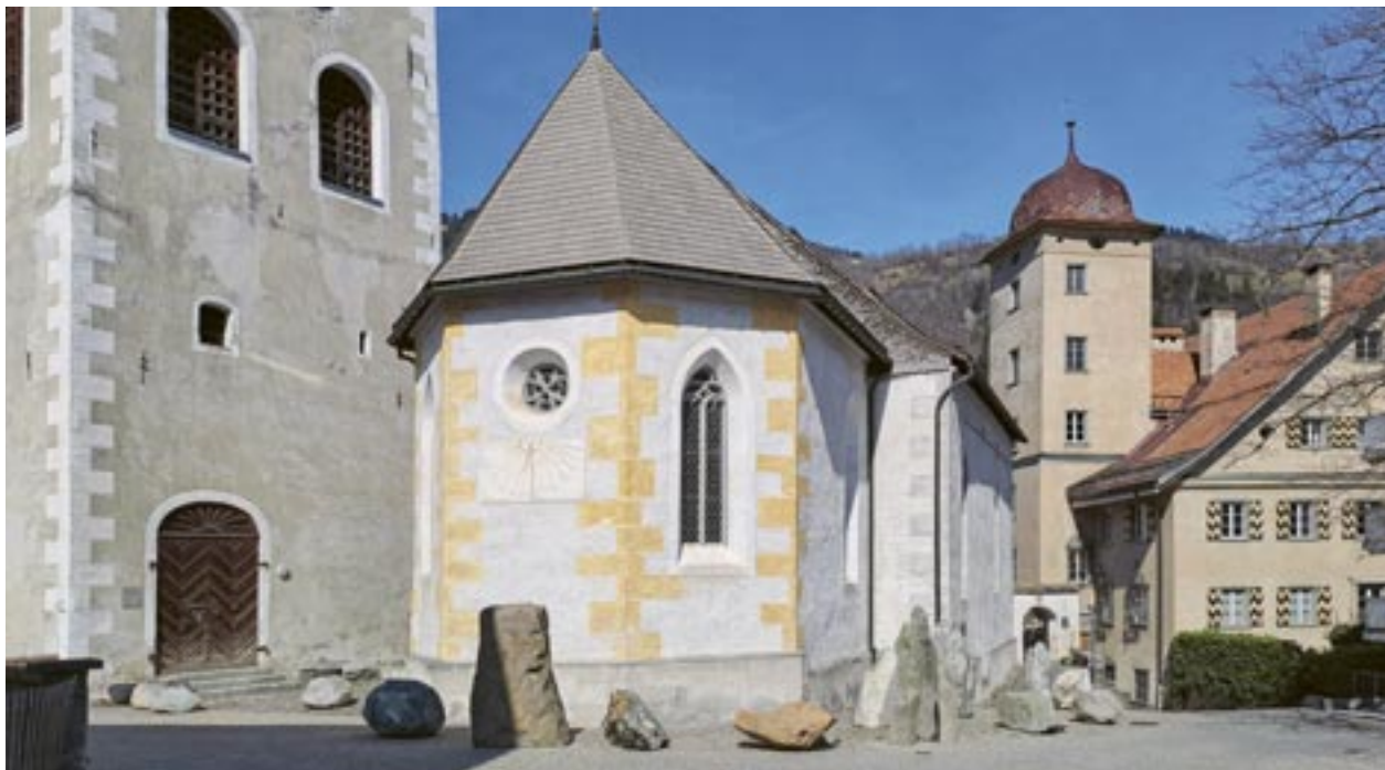
La piazza da s. Margreta cun la baselgia refomada s. Martin e la tuor marcanta dalla Casa Gronda.
