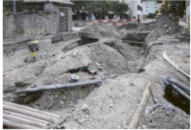
Per il remplazzament dallas lingias alla Porta Sura a Glion ha la via stuiu vegnir serrada per in pli liung temps.
