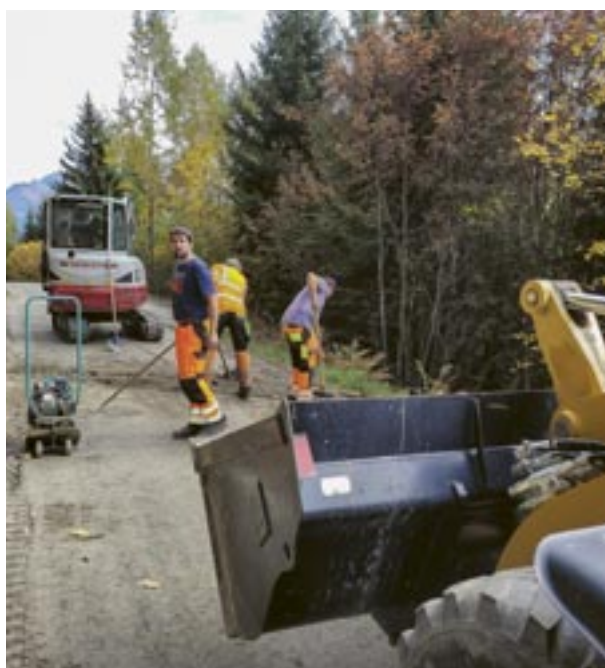
Collaboraturs dil menaschi tecnic tier l'installaziun dallas canals d'aua.
