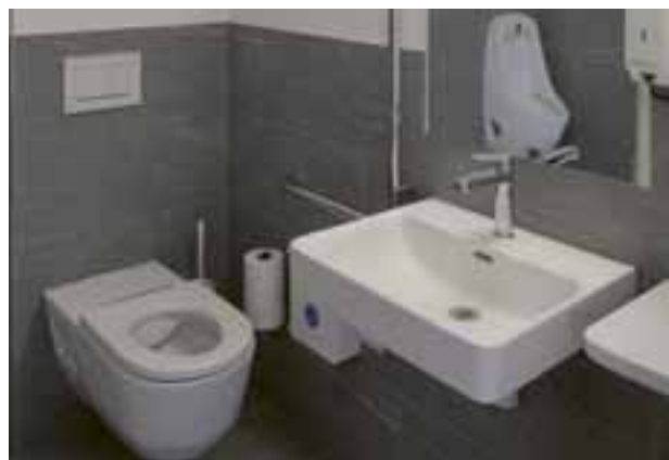
... und die öffentliche WC-Anlage in Siat wurden im Jahr 2021 fertig gestellt.
