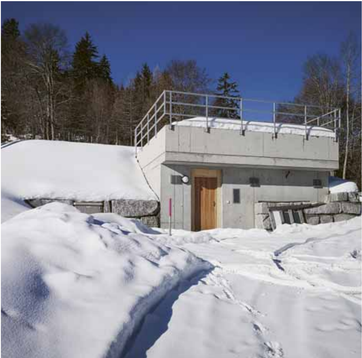
Das neue Wasserreservoir in Luven ist in Betrieb.
