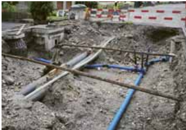
Sanierungsarbeiten an der Schulstrasse in Ilanz ...
