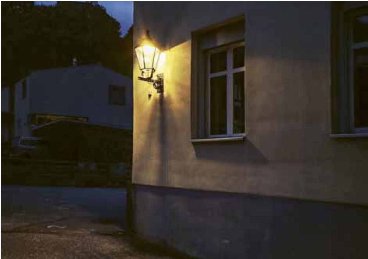
Die neue öffentliche Beleuchtung in Sevgein, welche auf LED-Lampen umgestellt wurde.
