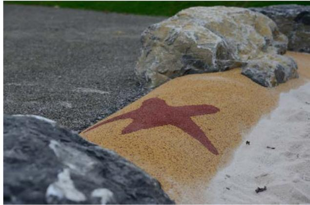
*Rundkies mit Einfassung aus Sickerbeton und PU-geb. Kunststoffbelag*
