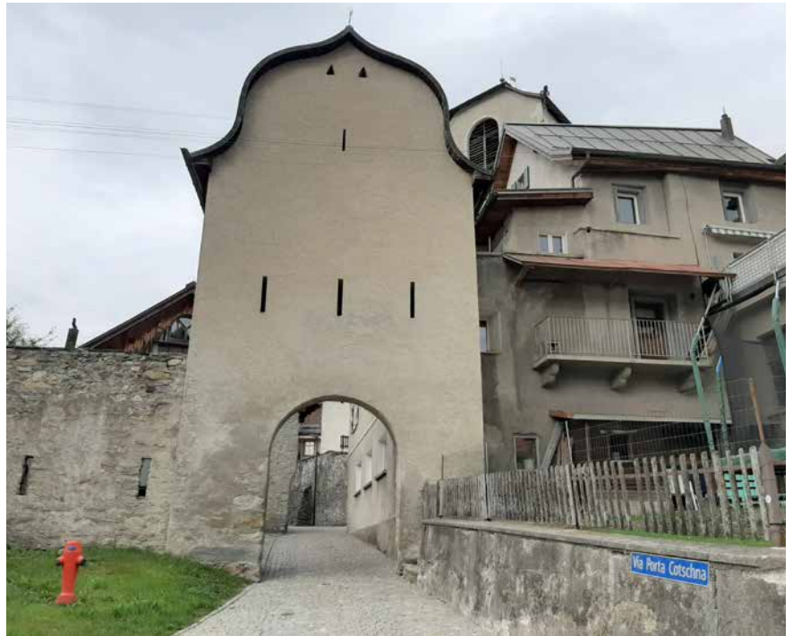
La Porta Cotschna, situada el nordvest digl anteriur mir che tschinclava il marcau, ei ina dalas attraziuns pitorescas da Glion.
