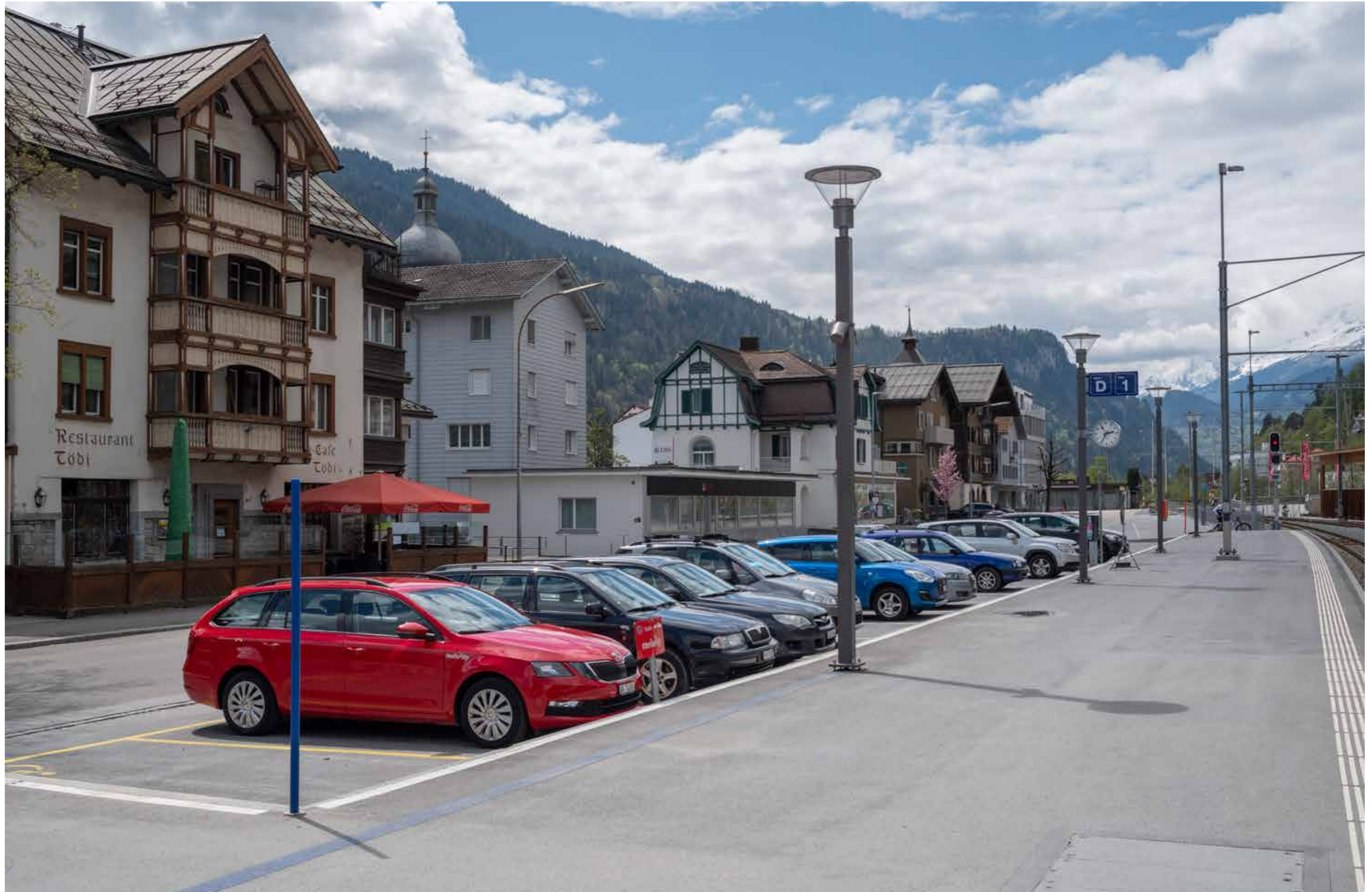
Aktuelle Situation Bahnhofsstrasse
