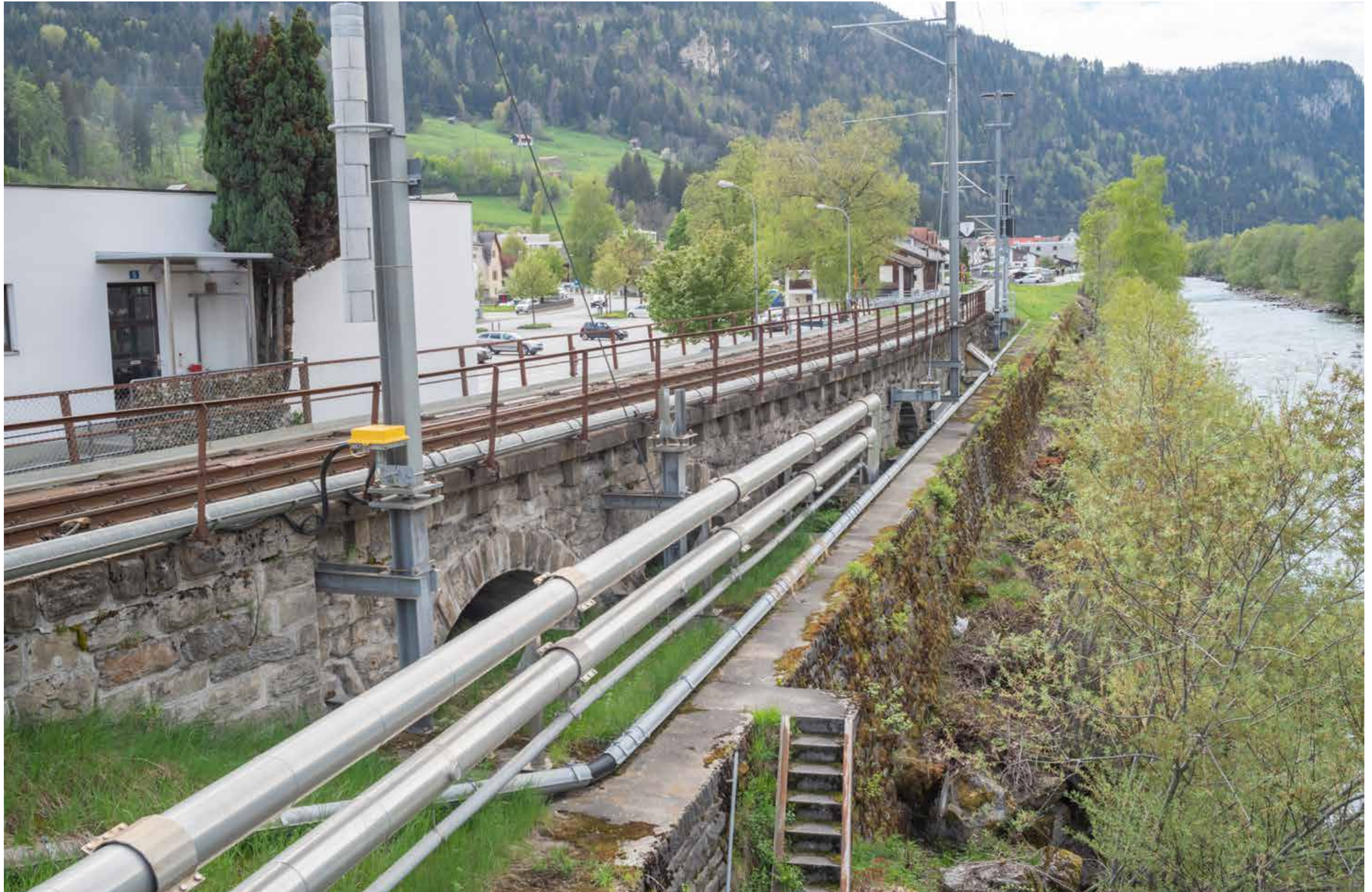
Eisenbahnbrücke, Blick in Richtung Marktplatz
